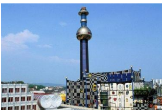
Vienne, usine d'incinération de Hunderwasser
